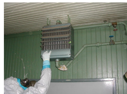
Provtagning vid misstänkt spridning via ventilationssystemet.
