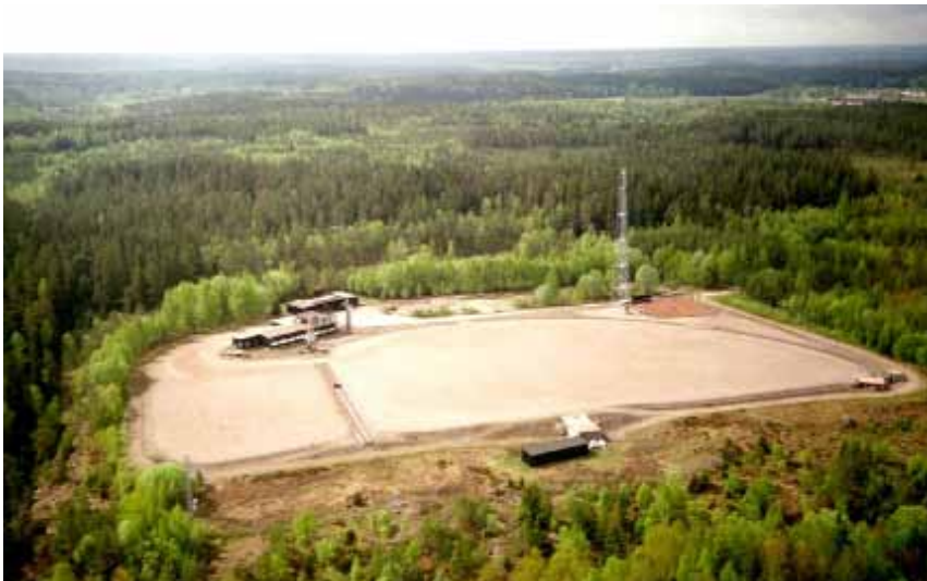
Lilla Gåra är en unik utomhusmätplats. Med stora vridbordet (längst till höger) kan mätobjekt upp till 80 ton mätas med hög precision.
