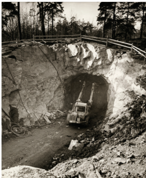
Figur 2. Bergsprängning pågår för bergrum där olja ska lagras av Oxelölager AB, OLAB. Fotografiet har inget angivet datum men i arkivet framgår att sprängningen påbörjades strax efter att OLAB bildades i februari 1973. Foto: Järnvägsmuseet.
