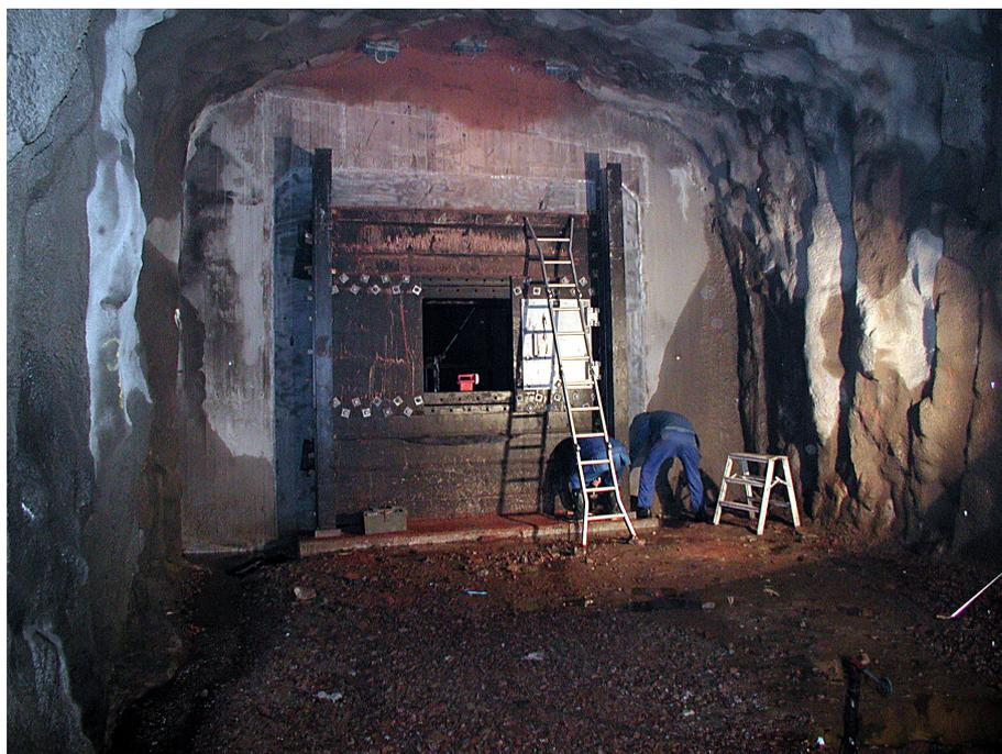
Bild 4. Barriären med 1 m<sup>2</sup> öppen.
