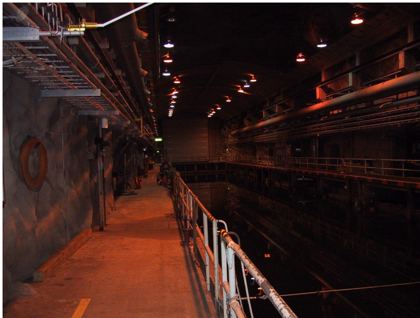
Figur 1. Interiör av docka 3
