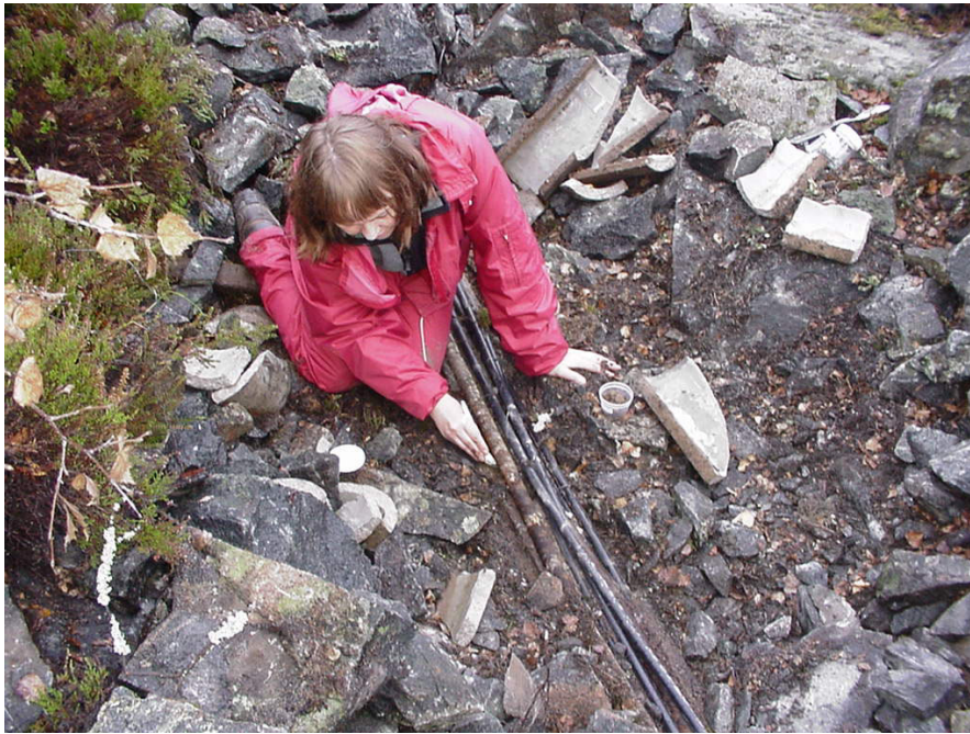
Figur 4. Provtagning av jord invid markkabel. Jordproverna analyserades senare med avseende på bl a mjukgörare (ftalater) och tungmetaller.
