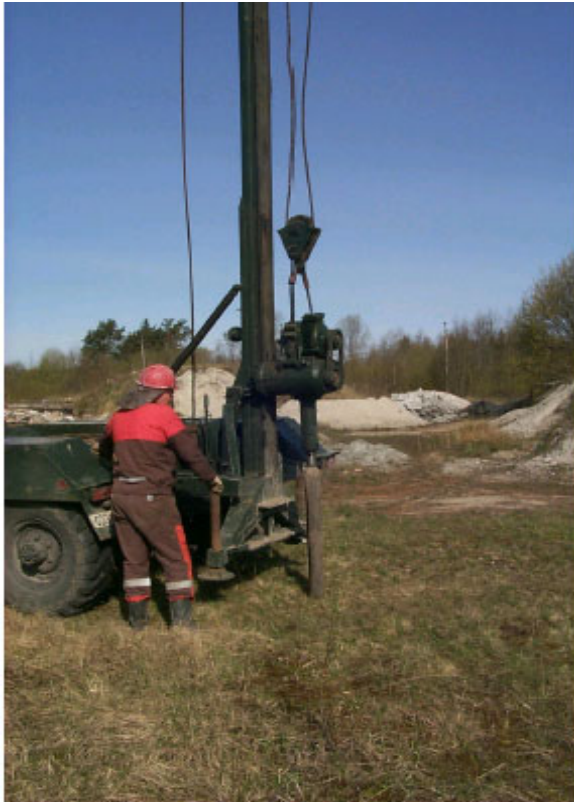
Figur 2. Installation av grundvattenrör på Ämari flygbas, Estland. Borrutrustningen är av beprövad och robust rysk modell.
