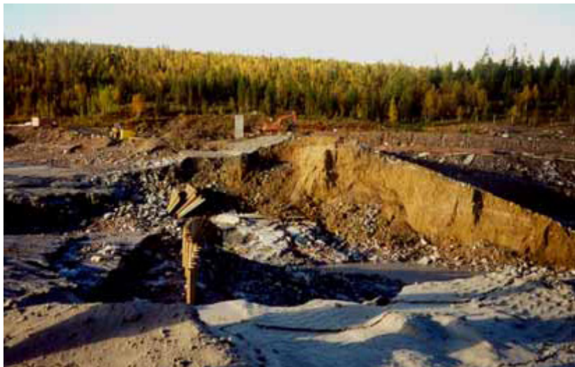
Bild 9. Foto tagit av platsen där vattnet bröt genom dammen som skiljer sandmagasinet från klarningsdammen i gruvdammen vid Aitik. Foto: Jan Olov Westerberg. (Ref. 68)
