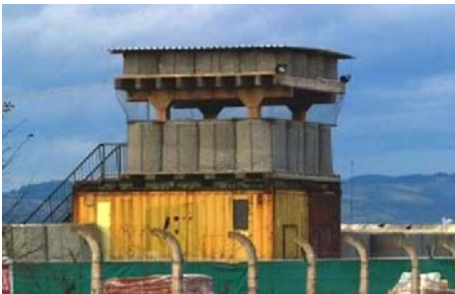
Figur 3.2 Skydd utformat med Hesco Bastions i Bosnien [5].
