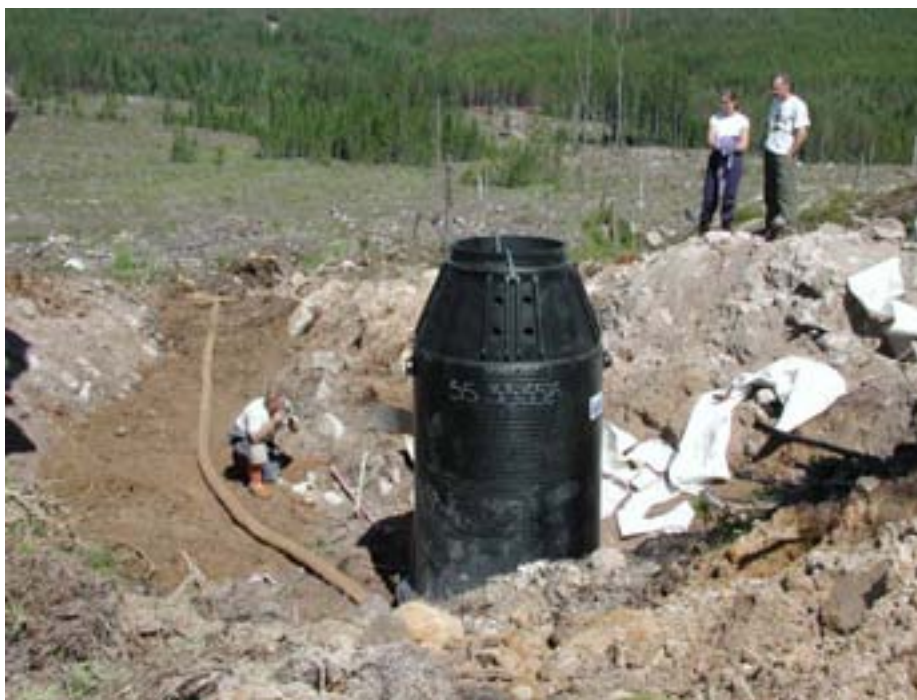
Figur 22: Nedgrävning av Uponor polyetylen mätbrunn övervakas av Malin Lennartsson och Björn Lund. Resultatet dokumenteras av representant från NCC.
