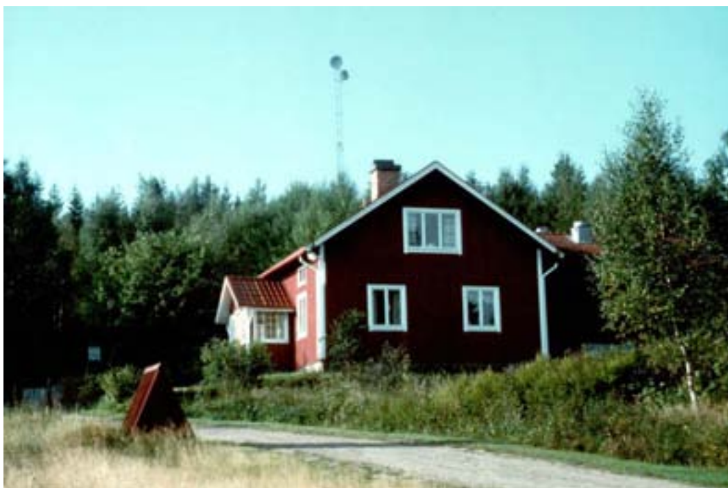
Figur 20: Hagfors huvudbyggnad med maskinhall till höger och mast för länkning av data från ytterpunkterna APO och SLL.
