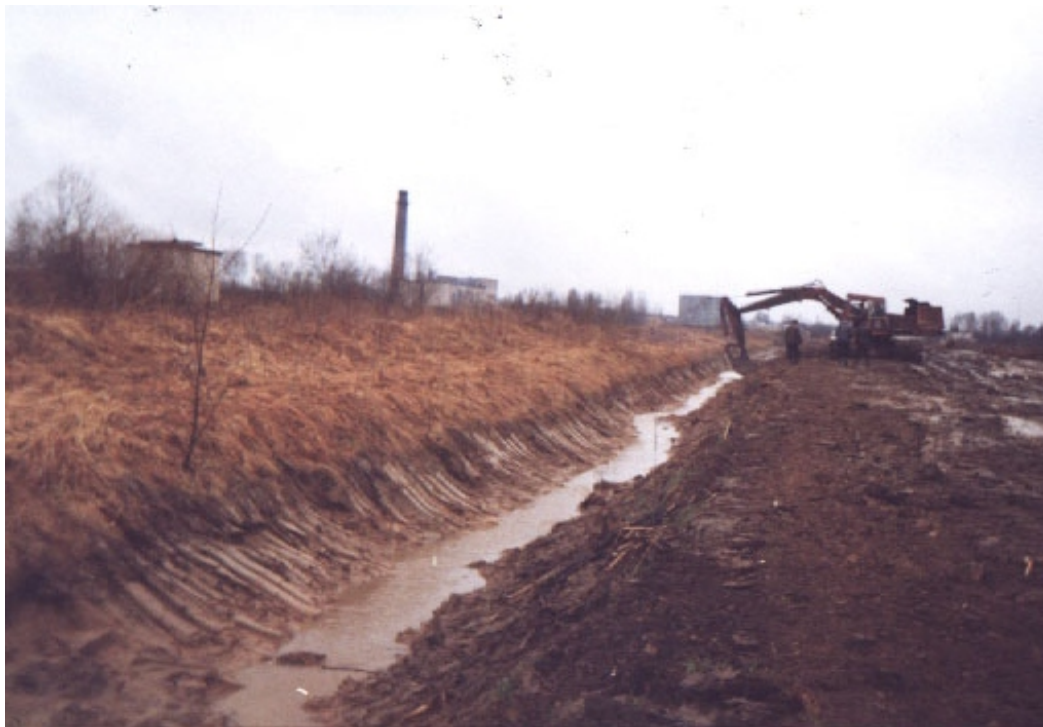
Figur 3. Grävning av miljösäkrande ringdike inför oljesanering av basområdet.
