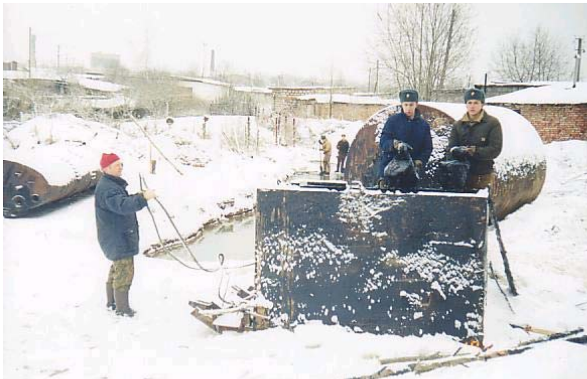
Figur 6. Specialkonstruerad container på medar för bortfraktning av oljeförorening vintertid.
