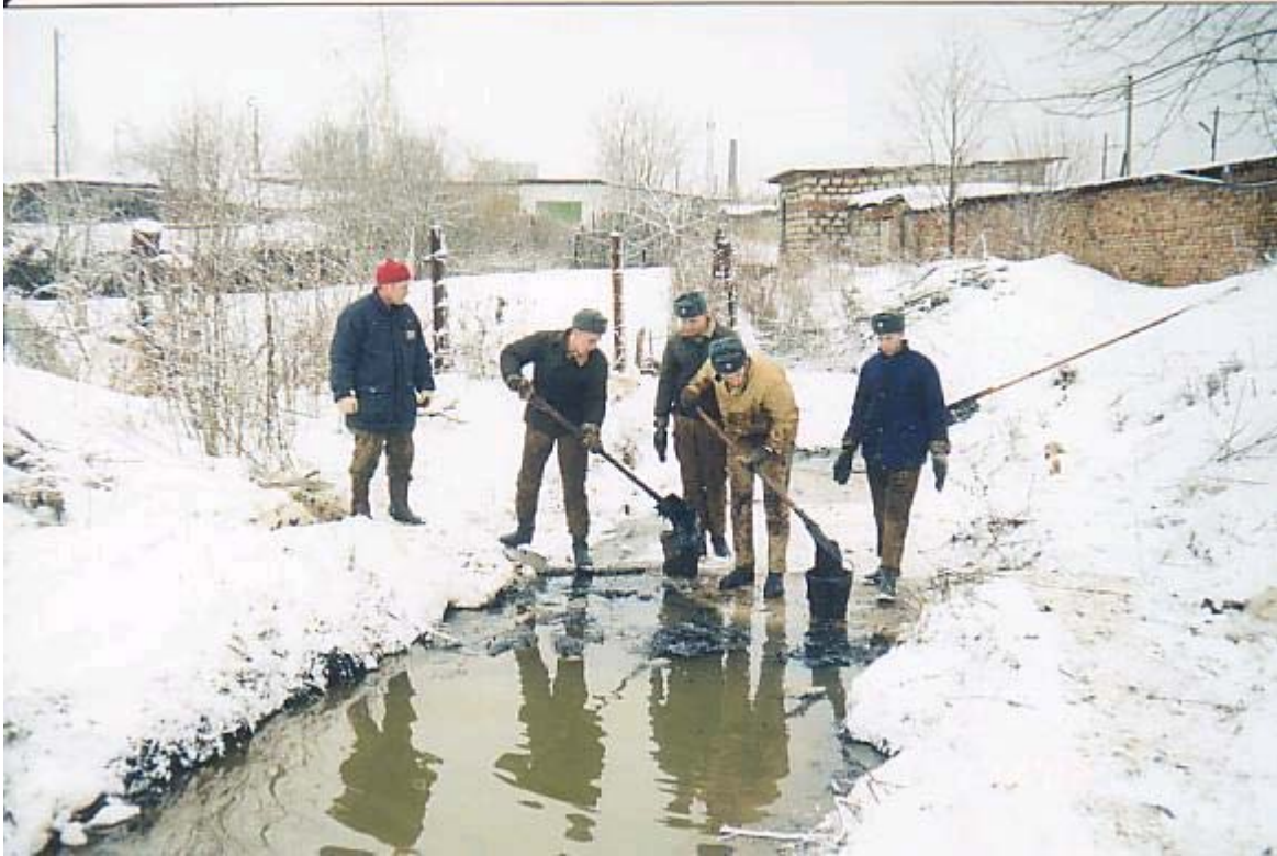
Figur 5. Manuell bortgrävning av oljeförorening.
