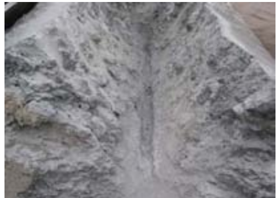
Figur A-20. Bild av hålskanal i betongelement.
