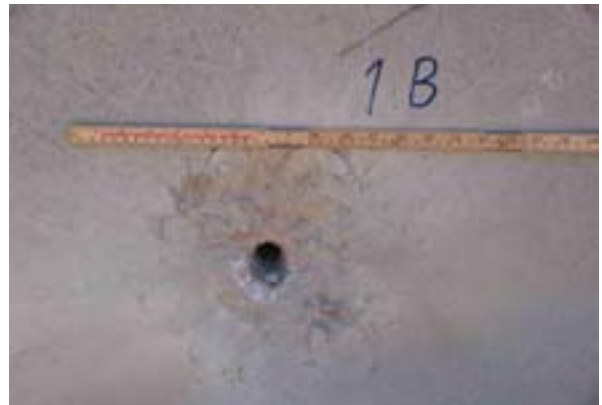
Figur B-8. Bild av baksida på det första betongelementet efter skott 2.
