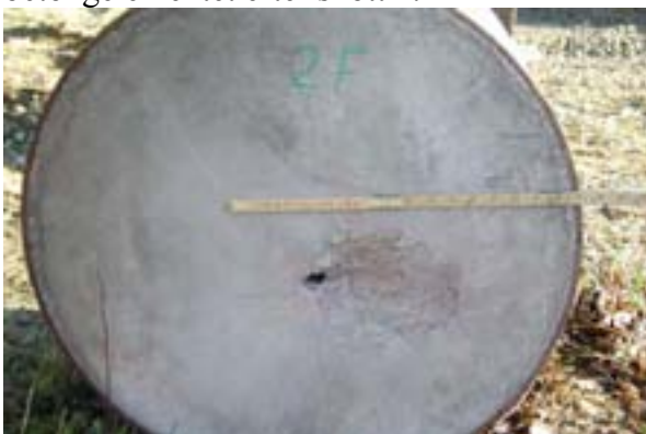
Figur B-27. Bild av framsida på det andra betongelementet efter skott 4.
