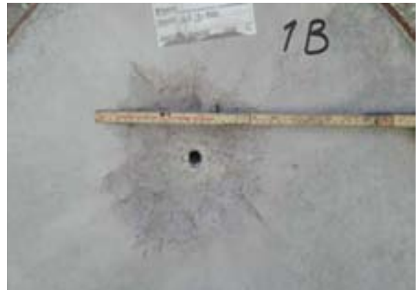
Figur C-12. Bild av baksida på det första betongelementet efter skott 3.
