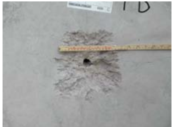
Figur C-4. Bild av baksida på det första betongelementet efter skott 1.
