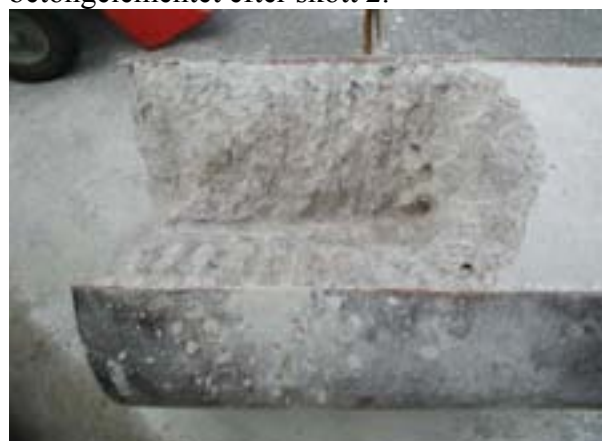
Figur B-12. Bild av hålskanal i det tredje betongelementet.
