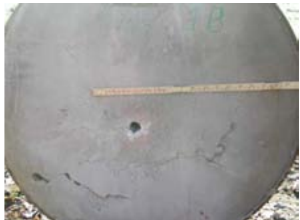
Figur B-26. Bild av baksida på det första betongelementet efter skott 4.
