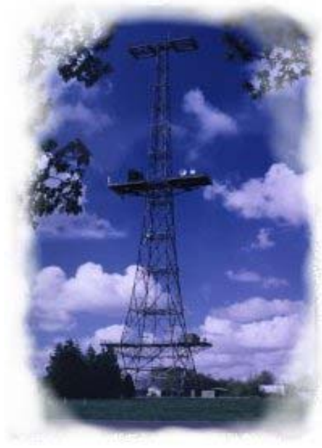
Figur 3. Det första exemplet på att radarstationer samordnades i ett nätverk var Chain Home. Bilden visar ett 110 m högt torn i Essex. Radarn använde låga frekvenser (30 MHz) och antennerna var känsliga för fysiska angrepp, en möjlighet som tyskarna försummade att utnyttja. Data förmedlades till sambandscentraler via telefon.
