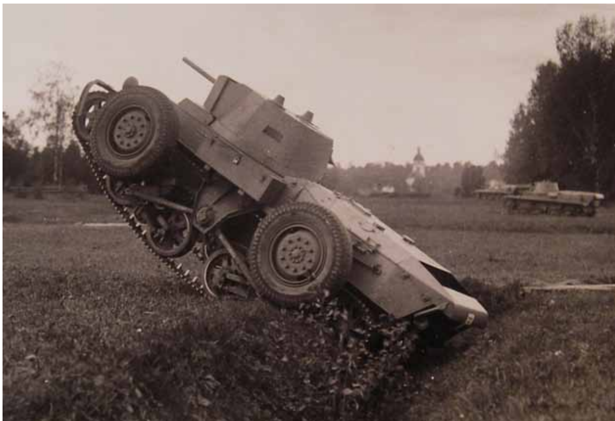
Fig 5.3 Att sikta högt med ny teknik. Hybridlösningen med både band- och hjuldrift var tekniskt sett en brygga mellan infanteriets och kavalleriets fordonsutveckling, men den kom inte att innebära något närmande mellan de båda truppslagens pansarambitioner. Här forceras ett dike med hjulen upphissade.
