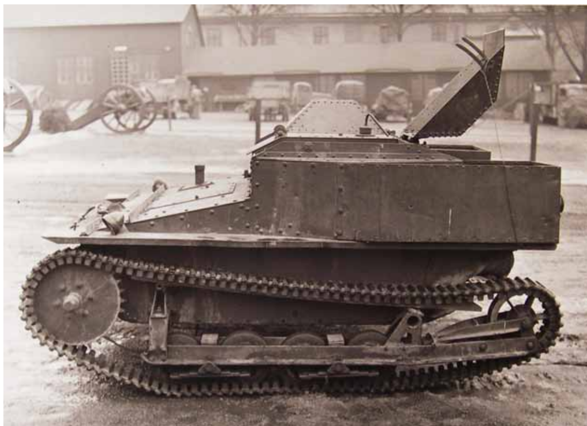
Fig 5.5 Teknik över truppslagsgränsen. Det engelska lätta pansrade fordon, vilket efter fyra år som dragfordon för artilleriet klassades om till stridsvagn.
