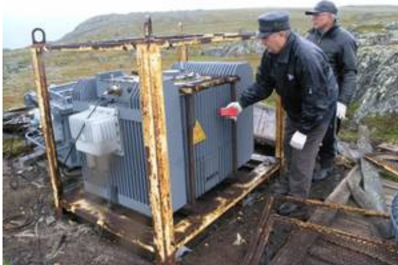
Figur 1. En gammal termoelektrisk generator (RTG) kontrolleras inför borttransporten. (Foto: Fylkesmannen i Finnmark.)
