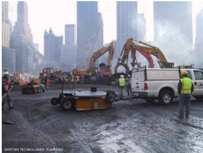
Figur 16. Bild av Witten Inc & Malå Geoscience CART-system (Computed-Assisted Radar Tomography) under arbete i samband med underjordisk kartläggning av "Ground Zero" (området där World Trade Center tidigare låg i New York).
