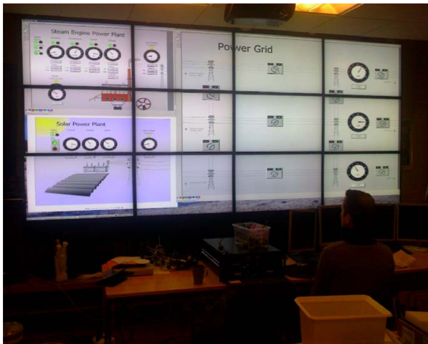
Figur 2: Exempel på operatörsplats under uppbyggnad.
