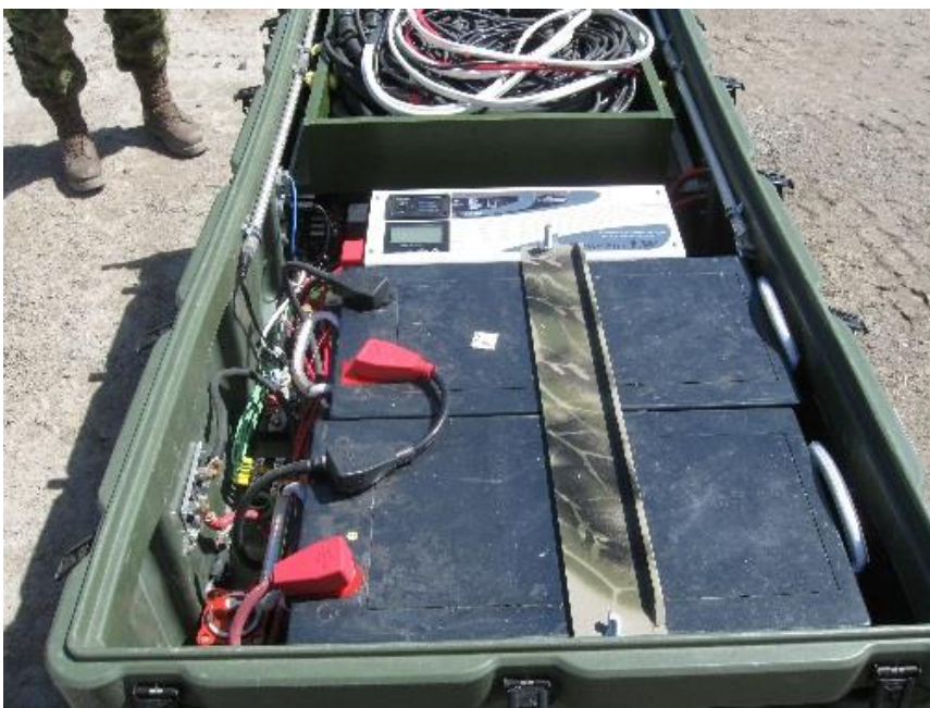
Figur 19. AGM-batterier och växelriktare i sin transportlåda. 78
