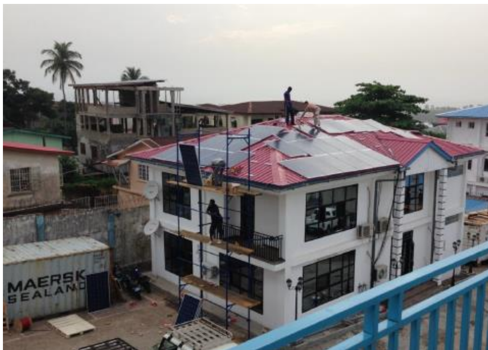
Figur 13. Installation av solpaneler på taket av gymbyggnaden. 70
