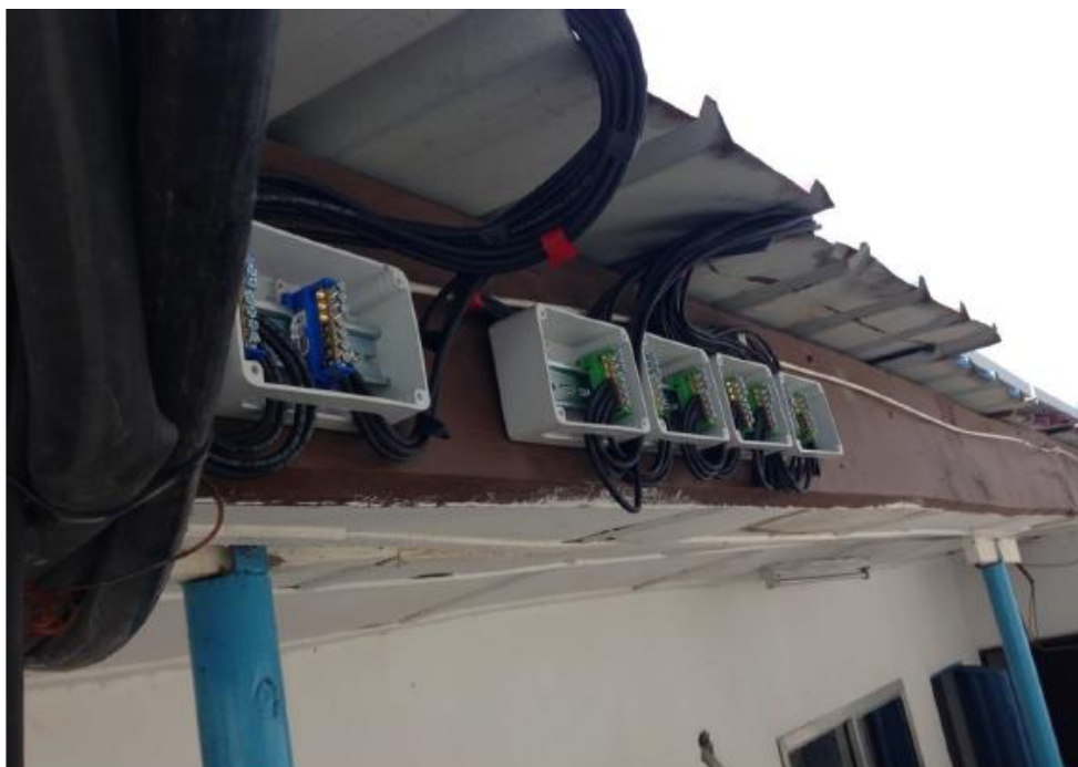
Figur 12. Inkoppling av solpanelerna på kantinbyggnaden. 69
