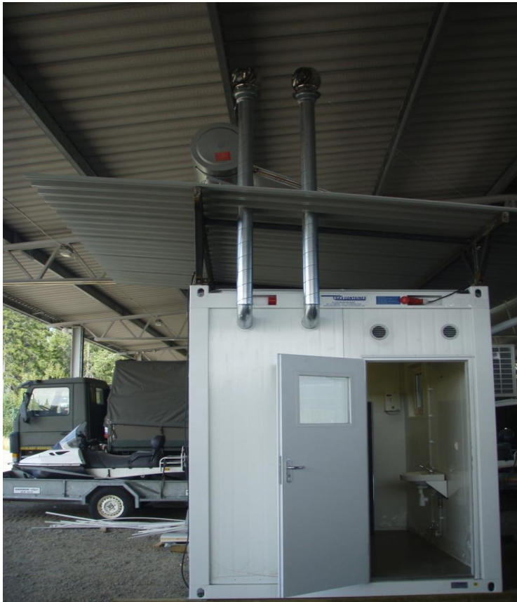
Figur 27. Provmontage av solpaneler, torrtoaletter, torr-urinoar och snålspolande dusch på kontorscontainern i samverkan med delegater från UNMISS, Umeå 2009.
