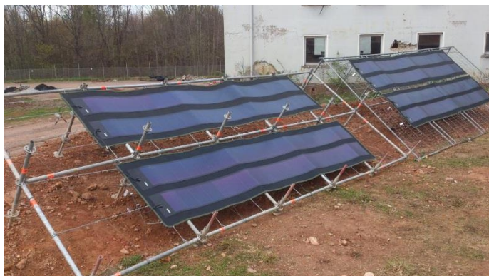
Figur 22a och b. Tunnfilmcellerna som användes i Afghanistan.
