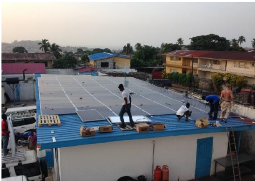
Figur 11. Installation av solpaneler på kantinebyggnaden. 68
