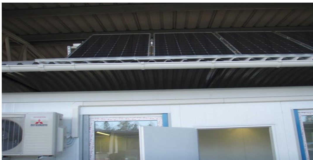
Figur 26. Provmontering av solpaneler, energibesparande soltak och extra isolering i väggar och golv m.m. på kontorscontainern, i samverkan med UNMISS, Umeå 2009.
