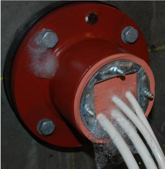
Serie 1 genomföring 10 trycksida efter installation före skott 1.
