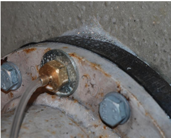
Serie 1 genomföring 12 baksida efter installation före skott 1.
