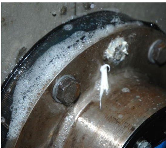
Serie 1 genomföring 14 trycksida efter installation före skott 1.
