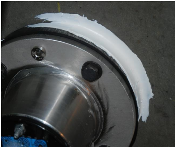
Serie 1 genomföring 13 trycksida efter installation före skott 1. Tätad med akryltätning.
