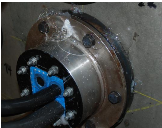
Serie 1 genomföring 15 trycksida efter installation före skott 1.
