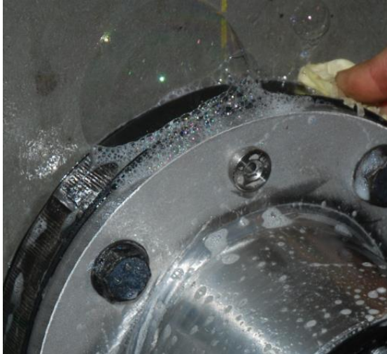
Serie 1 genomföring 13 trycksida efter installation före skott 1.
