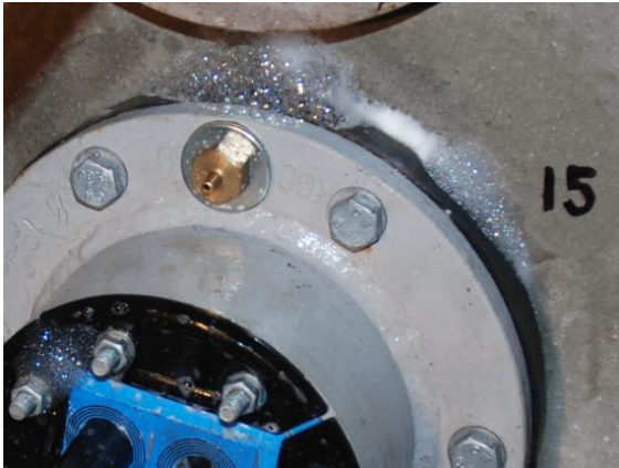
Serie 1 genomföring 15 baksida efter installation före skott 1.
