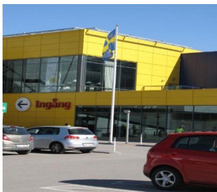
Figur 7 Flaggbelysning vid shoppingcenters entré som störde ut en basstation för GSM-nätet [13]. Foto: Henrik Olsson, Elsäkerhetsverket.
