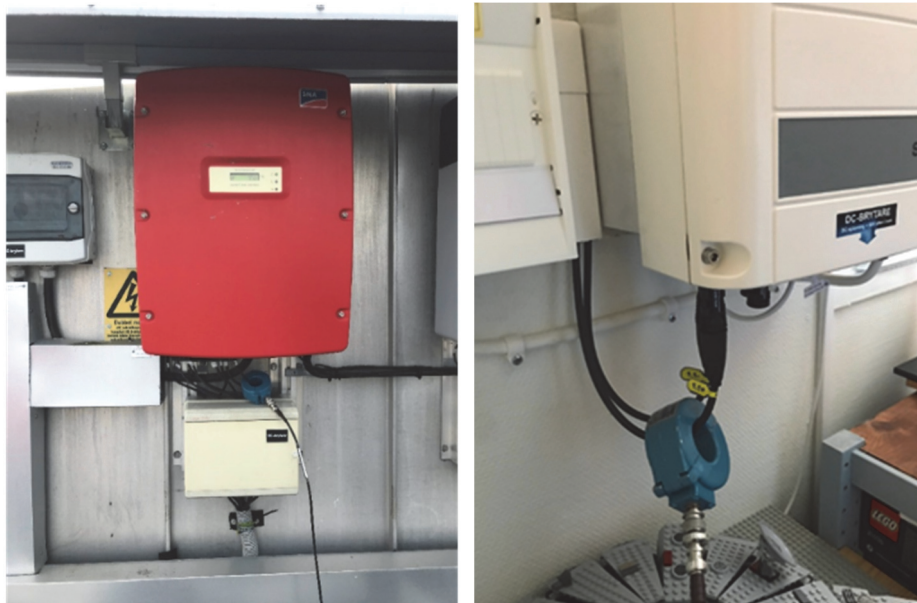
Figur 4. Bilder från mätningarna med strömtången vid växelriktarna, till vänster på taket på Tekniska verken och till höger inne i villan.
